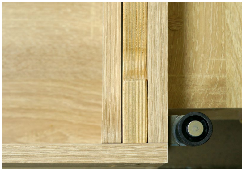
Ролик системы «антиперекос» на раме дивана
