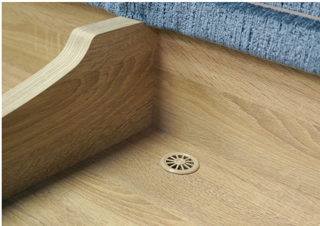
Вентиляционный канал в коробе
